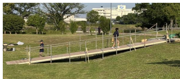
公園の自然に溶け込むよう、単管で支えながら木材の合板を使い温かみを大切に仕上げました。
