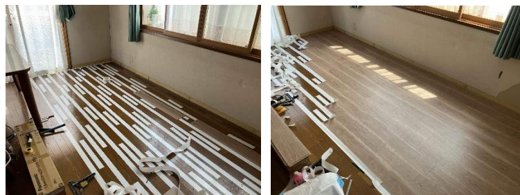
施工中の様子です。明るく、素敵なりビングになりました。
